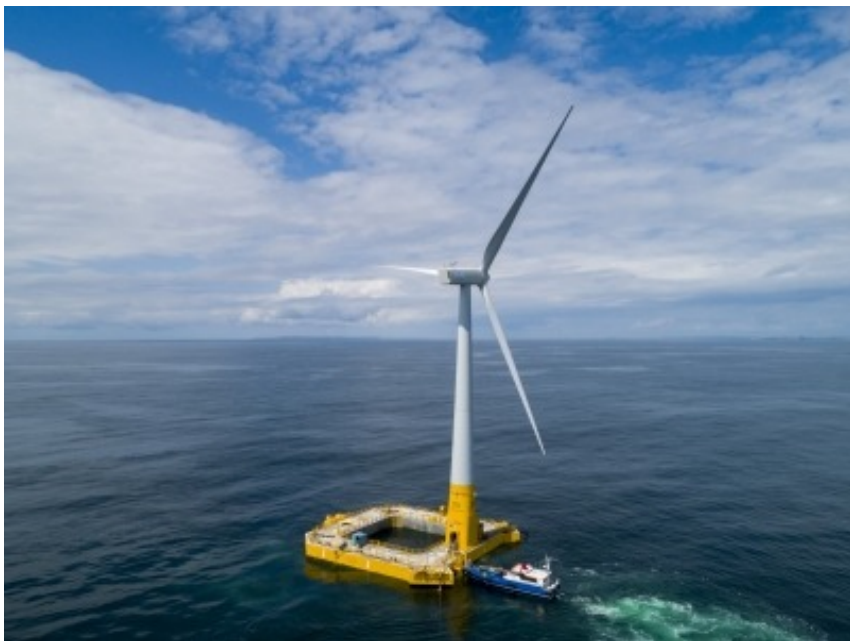
Floatgen, le démonstrateur d'éolienne flottante sur le site de SEM-REV (© Floatgen)
